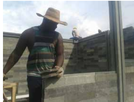
Construction using Collectivos Plásticos
